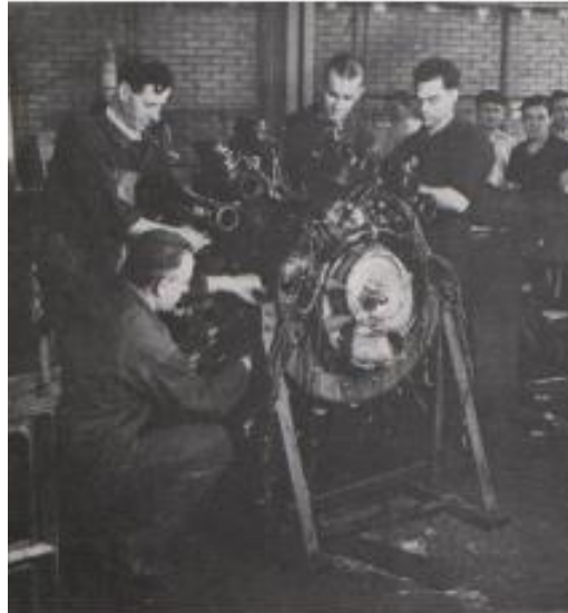
Figure 13- Démontage d'un moteur 14 N pour réparation 45
