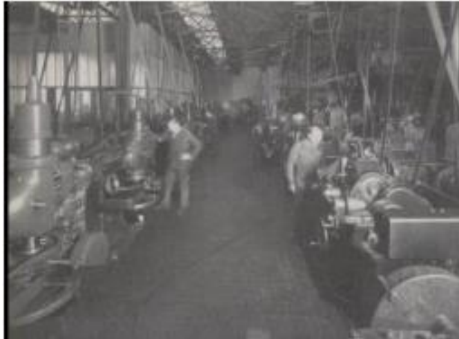
Figure 10- Atelier : machines pour tailler les engrenages 34
