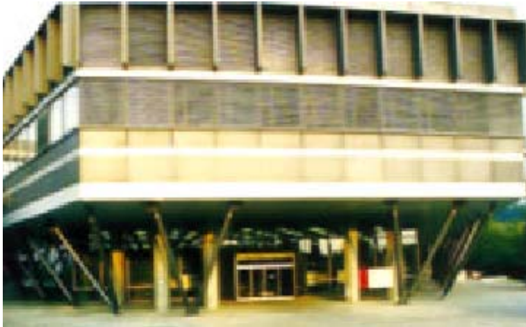
Contreventement à l'intérieur du bâtiment
