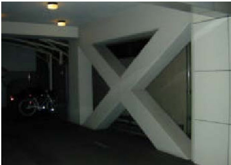
Contreventement à l'intérieur du bâtiment
