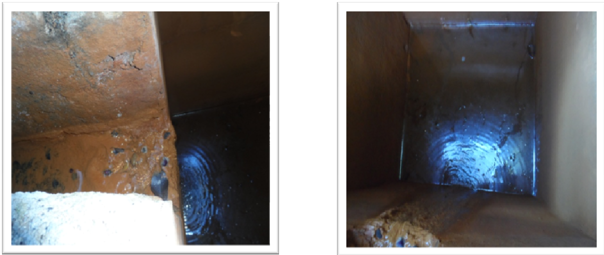
Figure 18: Intérieur du bassin B 2
