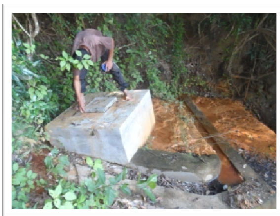
Figure 11: Vue extérieure du bassin de captage C_1
