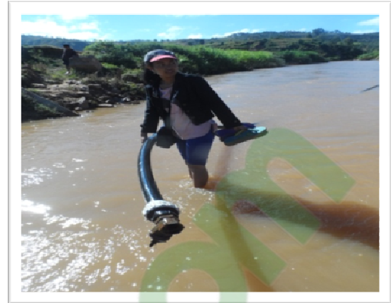
Figure 20: Tuyau d'amené en rupture traversant la rivière Sisaony
