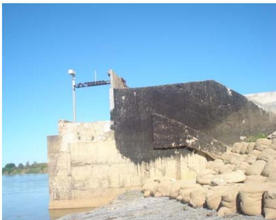
Photo n°3 : Protection provisoire en enrochement en aval de la prise
