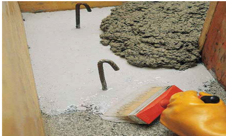
Figure II.5: Coulage du béton avec le produit Sika.
