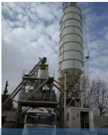
Figure 2. 25 : La récupération de béton frais par le camion malaxeur (photo prise par les auteurs)
