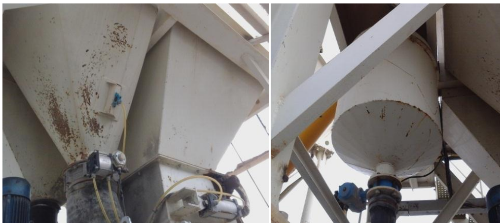
Figure 2.13 : Les dispositifs (photos prises par les auteurs)
