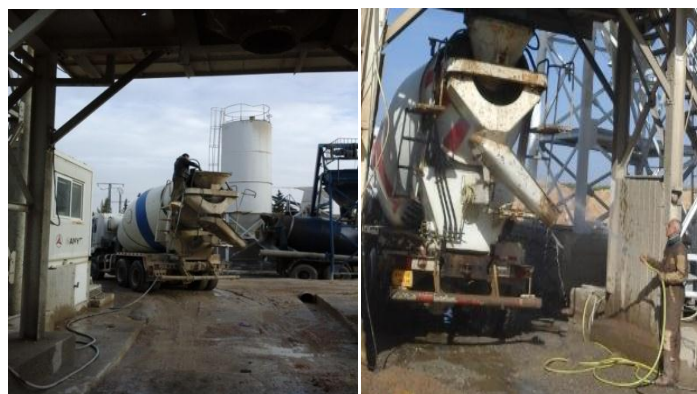
Figure 2. 34 : Nettoyage des camions malaxeurs (les deux centrales : Sogerhwit et Dennouni) (photos prises par les auteurs)
