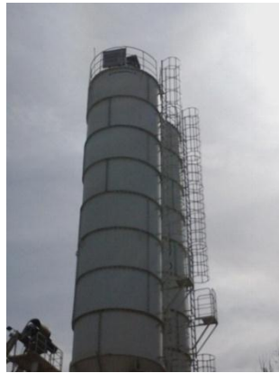
Figure 2. 14 : les Silos de stockage du ciment (photo prise par les auteurs)
