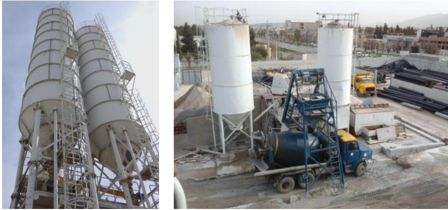
Figure 2. 5 : Les silos de stockage de ciment (photos prises par les auteurs)
