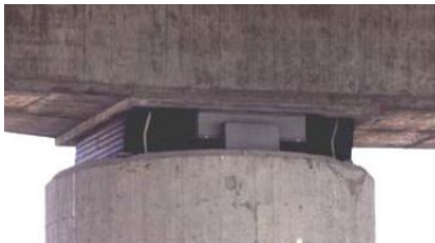
Figure V.1 : Photo réelle d'un appareil d'appui
