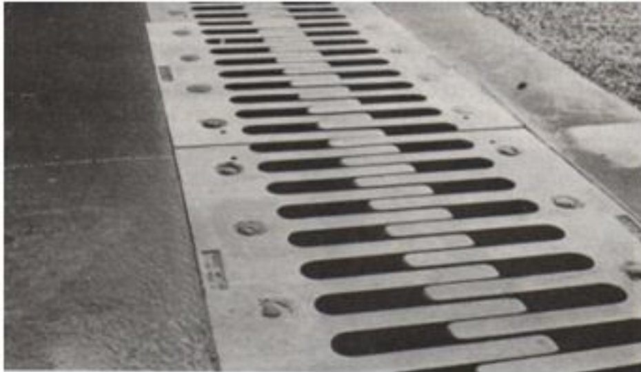
Figure V.11 : Joint de chaussée
