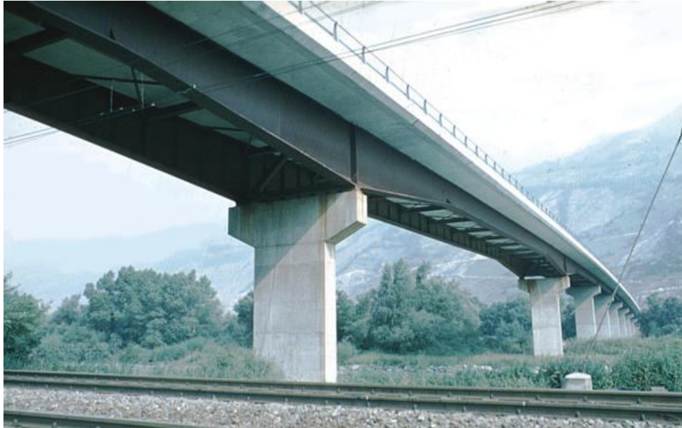
Figure I.7 : un exemple de pont mixte bipoutre
