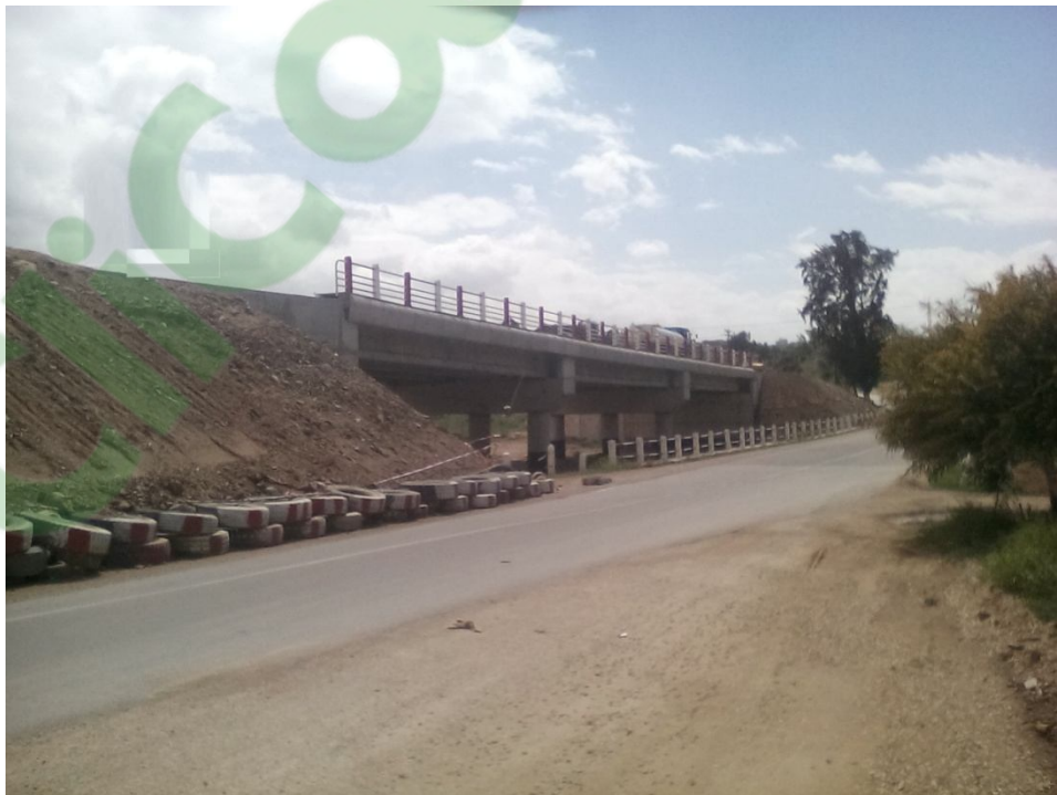
Figure II.2 : le pont existant vue de loin
