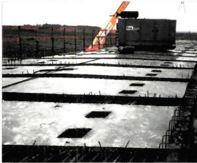
Figure IV.8 : les plots préfabriqués de la dalle
