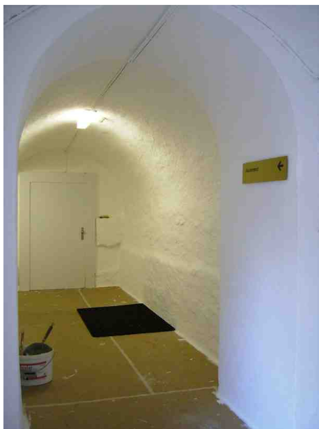
Photo 8 - couloir menant à l'ascenseur, en rénovation
