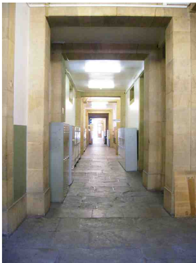
Photo 12 - couloir de l'entrée est du bâtiment
