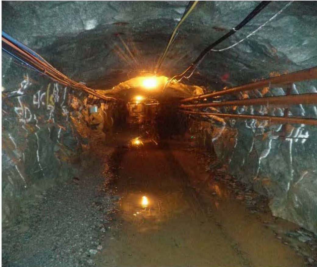
Figure 4-4:Galerie minière au niveau 70m
