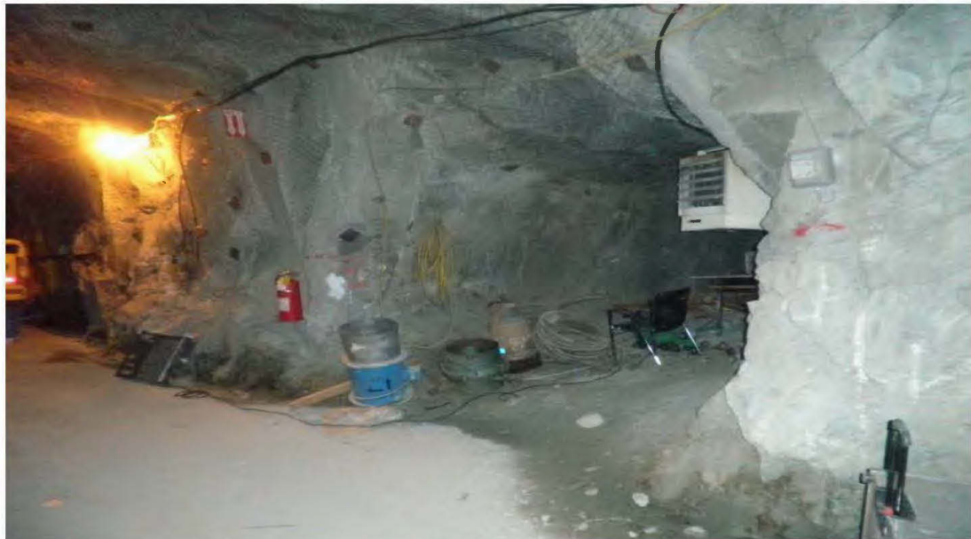
Figure 4-8: Photographie de la galerie en non-ligne de vue au niveau 40m
