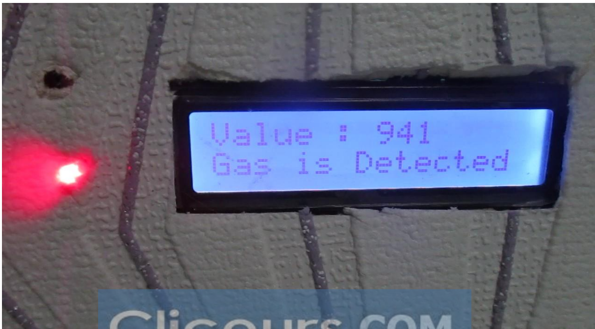
Figure III.11 : Détection de la présence de gaz.
