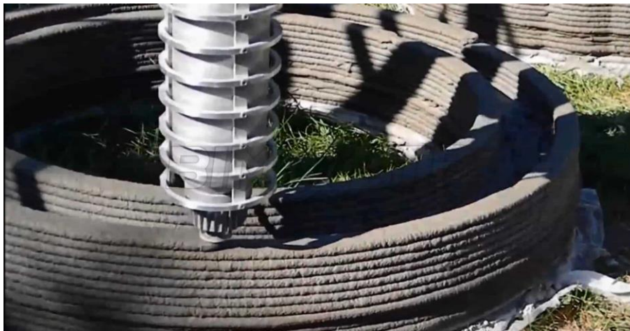
Figure 28. Tête d'impression d'une imprimante 3D béton
