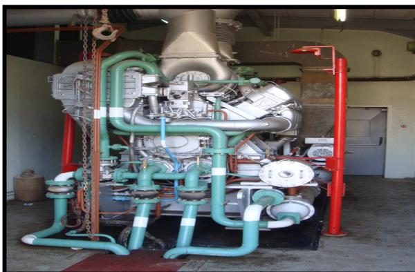
*Figure I.12 : Groupe diesel de secours, de la centrale de Bab Ezzouar*
