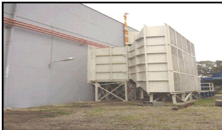
*Figure I.7 : Système d'admission d'aire de la centrale de Bab Ezzouar*
