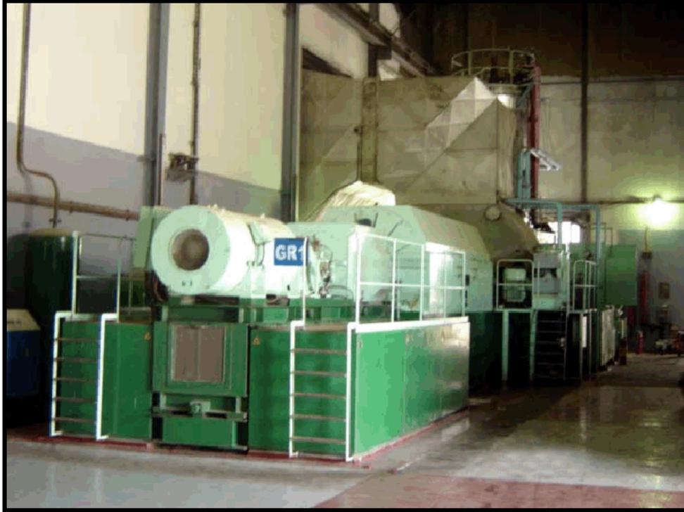
*Figure I.3 : Groupe turbo-alternateur de la centrale de Bab Ezzouar*
