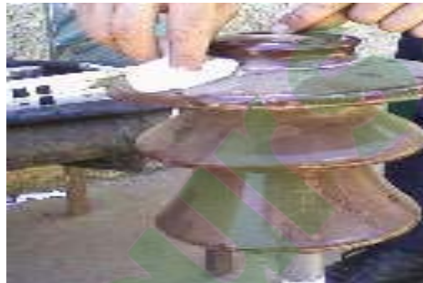
Fig. IV.11 Procédé de lavage de la surface d'isolateur
