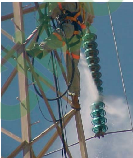
Fig.III.2 Lavage sous tension
