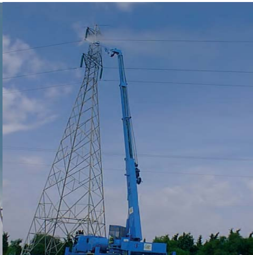
Fig.III.3 Lavage sous tension avec camion à bras télescopique
