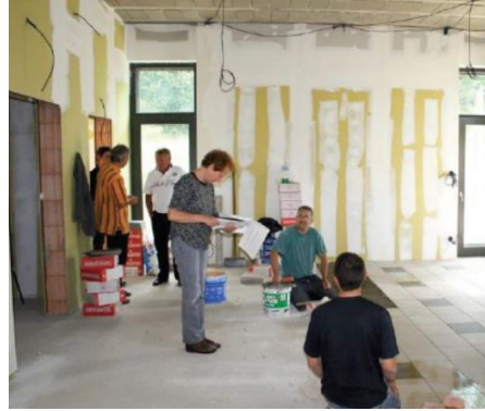
Figure 34 le chantier de la Mairie
