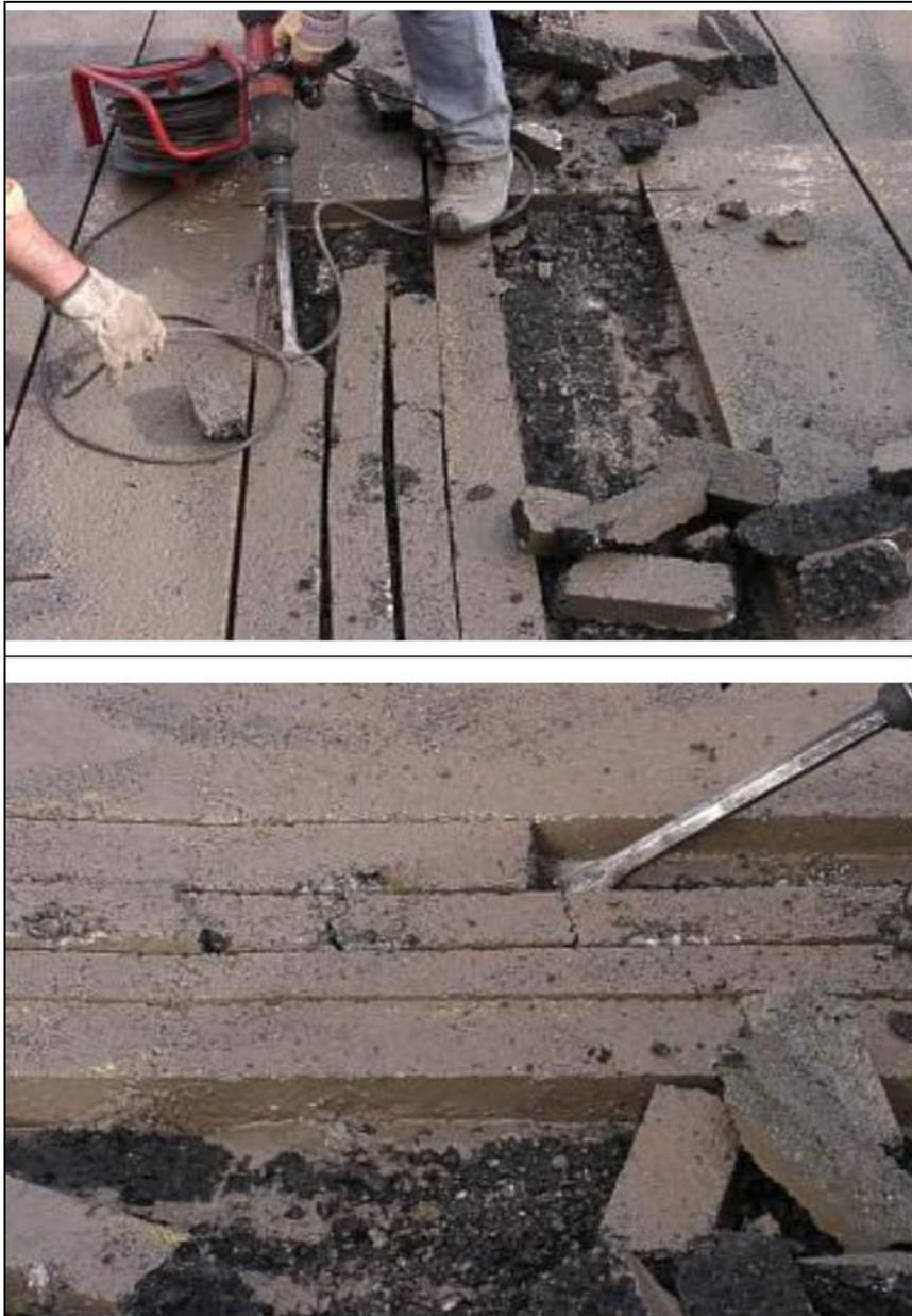
Figure 3.16 Excavation pour installer un système piézo (IRD, 2001)
