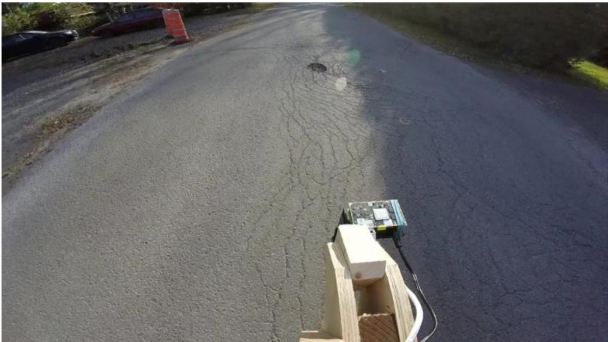
Figure 6.4 Image 54 fissure longitudinale, nid-de-poule et fissure en carrelage alligator
