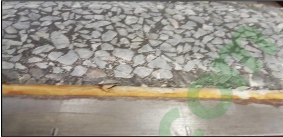
Figure 5.22 Joint de plâtre pour réduire les mouvements.
