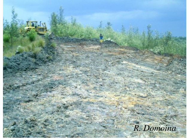
Décapage d'une colline à la mine IX
