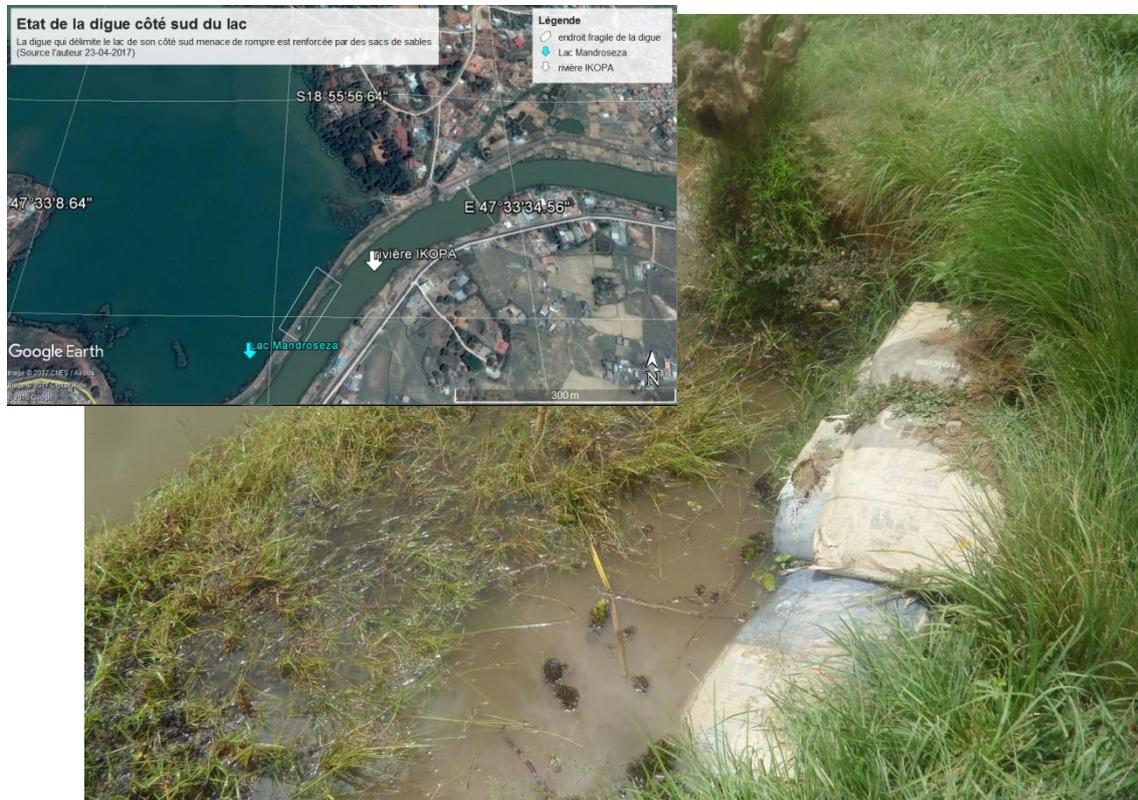
**Figure 28: la digue du côté sud du BV de Mandroseza renforcée par des sacs de sables**
