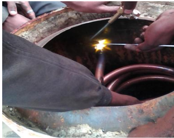
Photo 17: Mise en place de l'échangeur dans le réservoir
