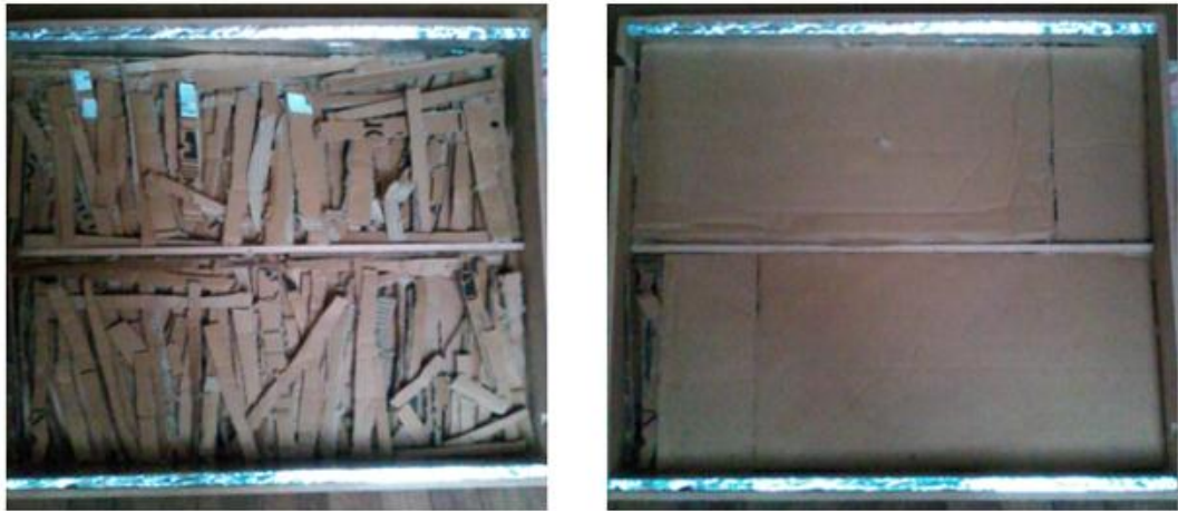
Photo 11: Isolation du bas du coffre
