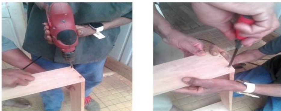
Photo 2: Perçage et mis en place des vis à bois
