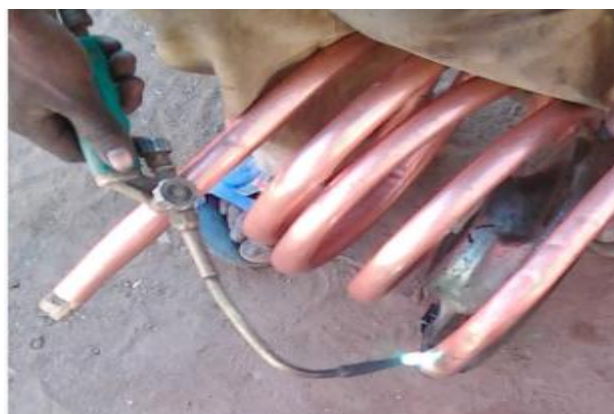
Photo 16: Réalisation de l'échangeur
