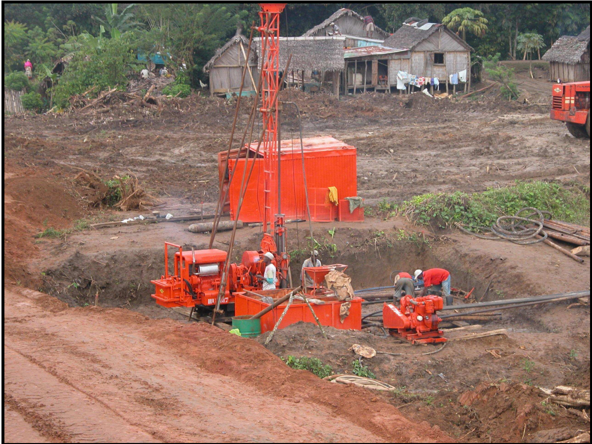
Photographie 5: Equipements de machine sondeur
