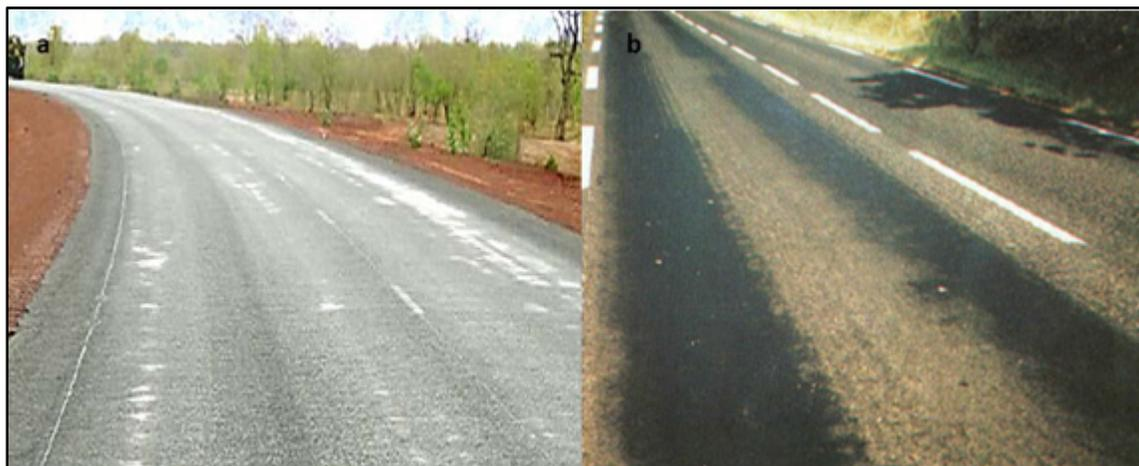
Figure 2.4 Ressuages (a) Ressuage à gravité faible ; (b) Ressuage à gravité majeure
