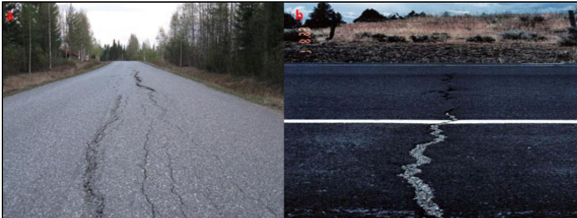
Figure 2.3 Fissures (a) Fissure longitudinale ; (b) Fissure transversale
