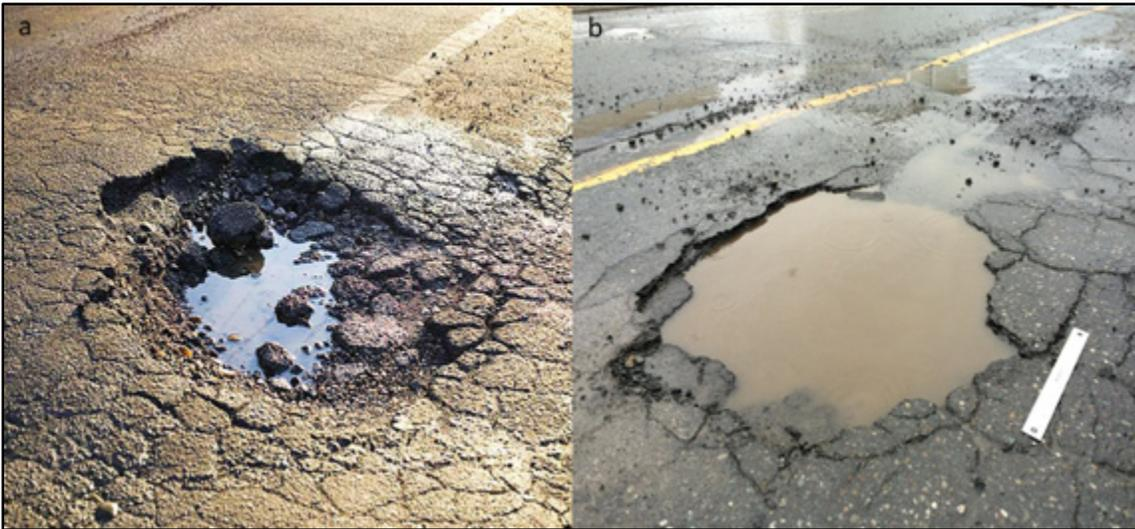
Figure 2.2 Nids de poule (a) nids de poule à niveau faible ;
