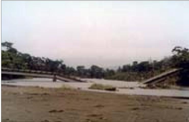
Figure 1.11 Effondrement d'une travée du pont
