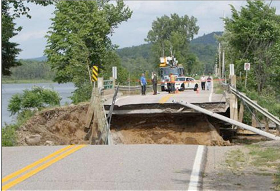
Figure 0.2 Dommages causés par le séisme de Val-des-Bois au Québec sur un pont près d'Ottawa
