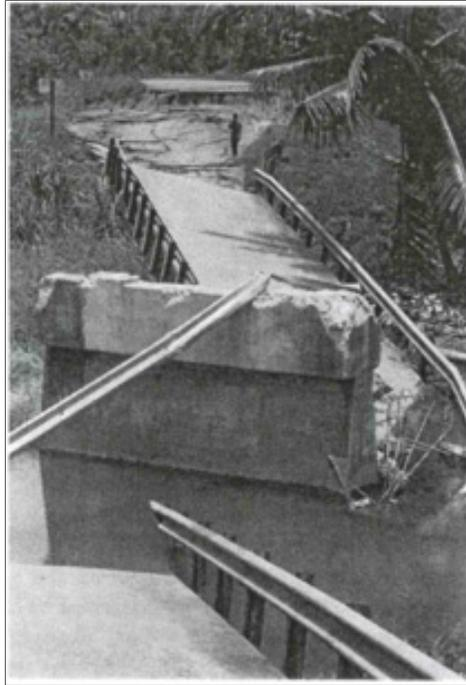
Figure 1.10 Perte d'appui et rupture d'une travée du pont Rio Bananita construit sur des sédiments de faibles résistances au cisaillement, (Costa Rica 1990)
