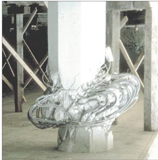
Figure 1.8 Rupture d'une colonne lors du séisme de Northridge (1994)
