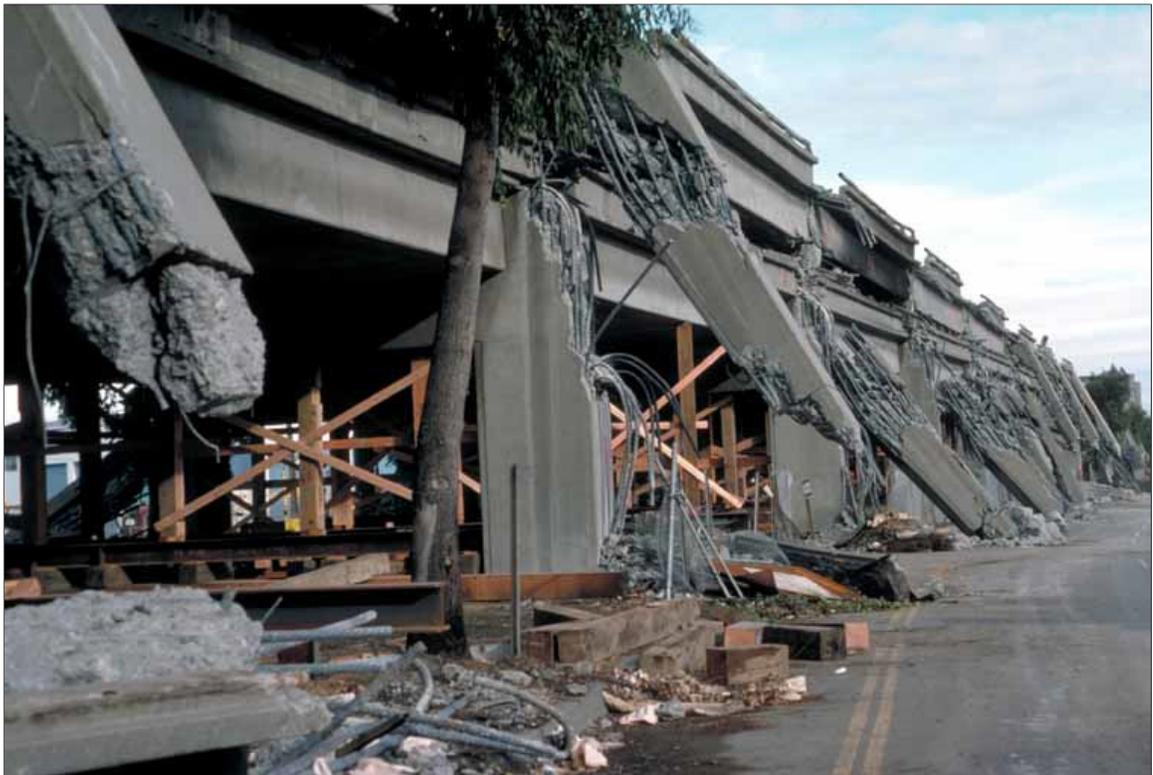
Figure 1.9 Rupture des assemblages, viaduc Cypress (Loma Prieta, 1989)
