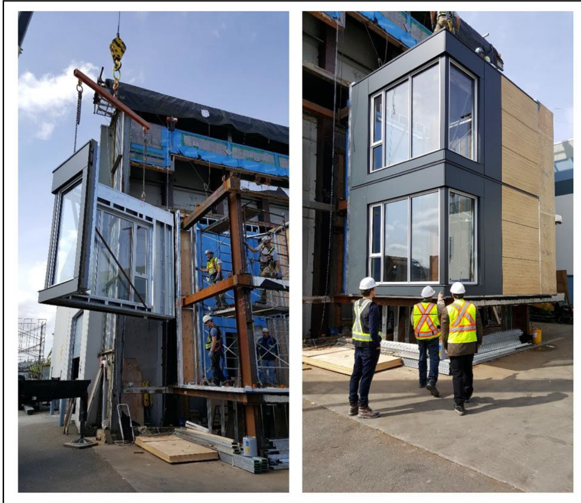
Figure 4.25 Portion de façade d'angle préfabriquée en manutention Tirée de TOPICs Lab (2016)
