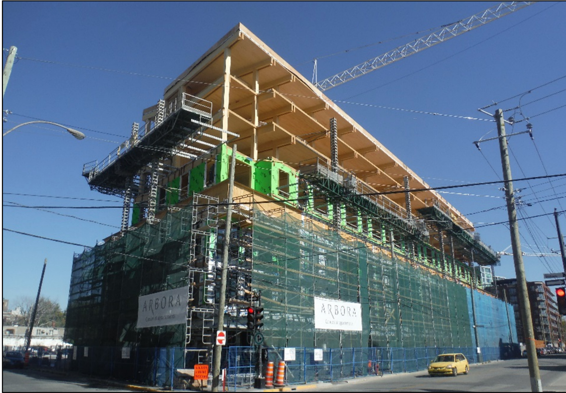
Figure 4.9 Photo du chantier Arbora 1 – Phase 1
