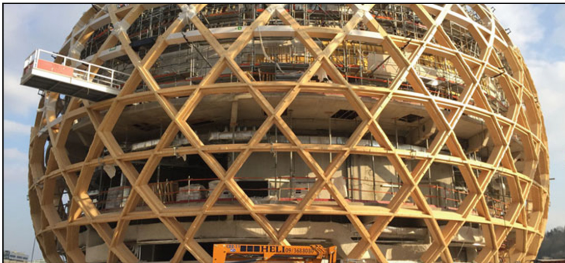
Figure 2.11 La Seine Musicale en cours de réalisation Shigeru Ban et De Gastines Architectes, Usai et Stehling (2018)
