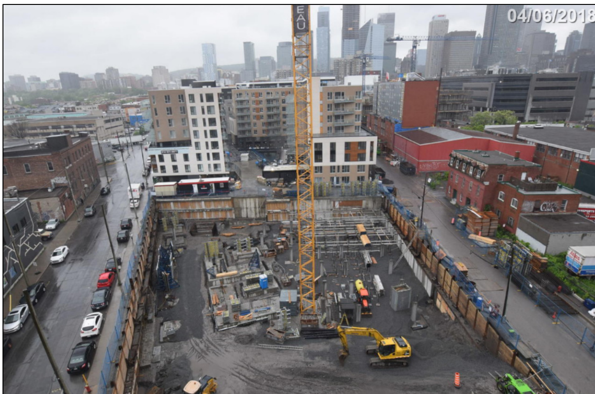
Figure 4.17 Arborescence 3 – Début du chantier de la phase 3 Juin 2018 (source : Devisubox)
