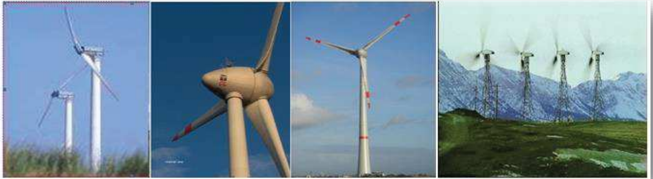
Figure I.2 : Aéro-générateur à axe horizontal.
