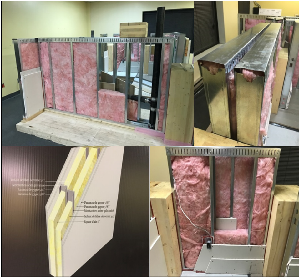
Figure 2.7 Photographies de coupes des cloisons de ARBORA
