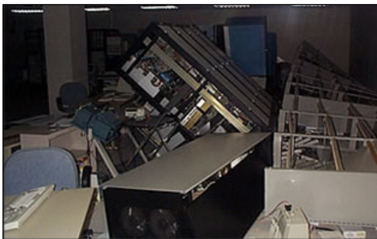
Figure 1.6 Renversement des étagères (séisme de Nisqually en 2001) http://www.ccsgroupstl.com (consulté en mars 2017)
