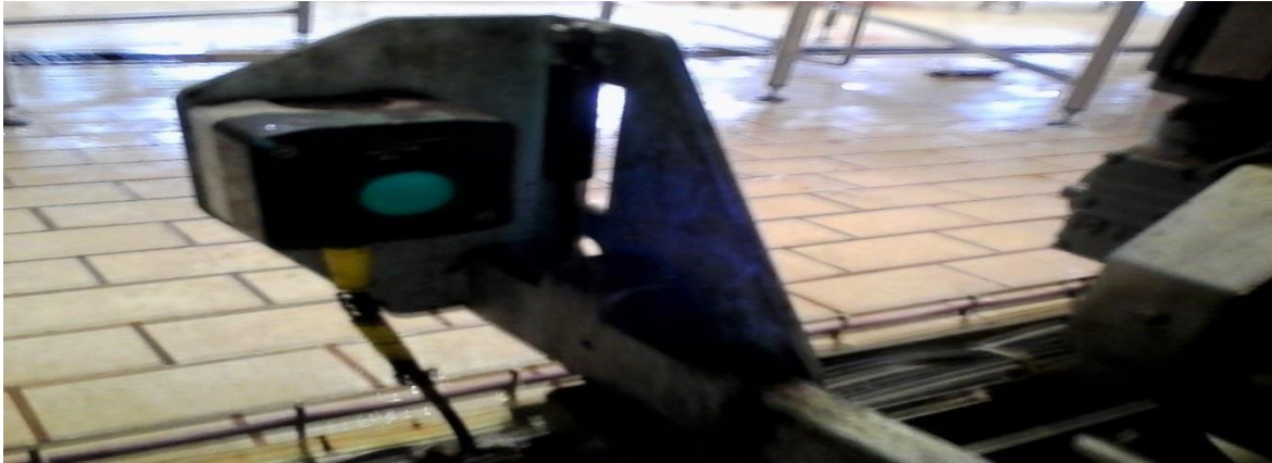
Figure 27: Relâche de la barre de soudure.[7]
