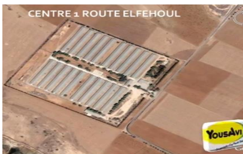
Figure 3.2 Situation géographique de centre 1
