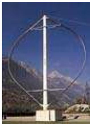
**Figure2-7.** Photographie d'une éolienne de Darrieus [11]
