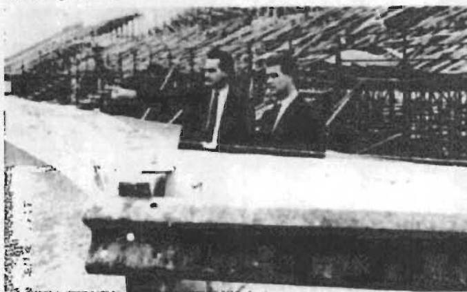
FURY SPEEDWAY EN DEMOLITION — M. Jean Giosi explique au constructeur M. Gilbert comment s'effectue la démolition de la piste de courses Fury Speedway de Fabreville.
