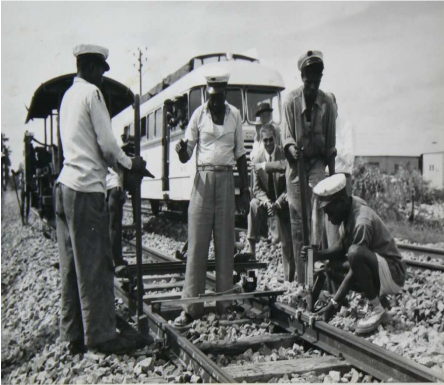
Image 2 : Pose des rails
