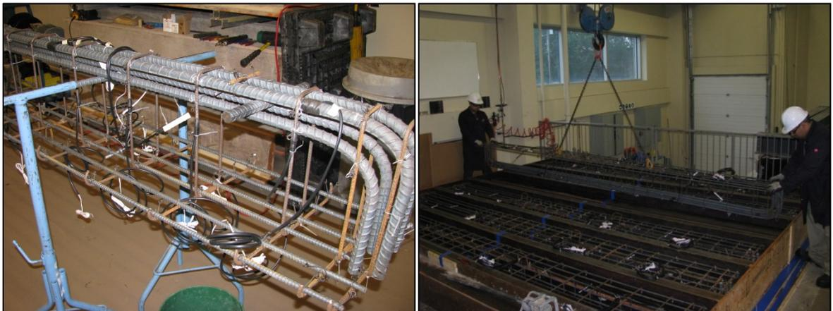
Figure 3. 3 Montage de l'armature et du coffrage
