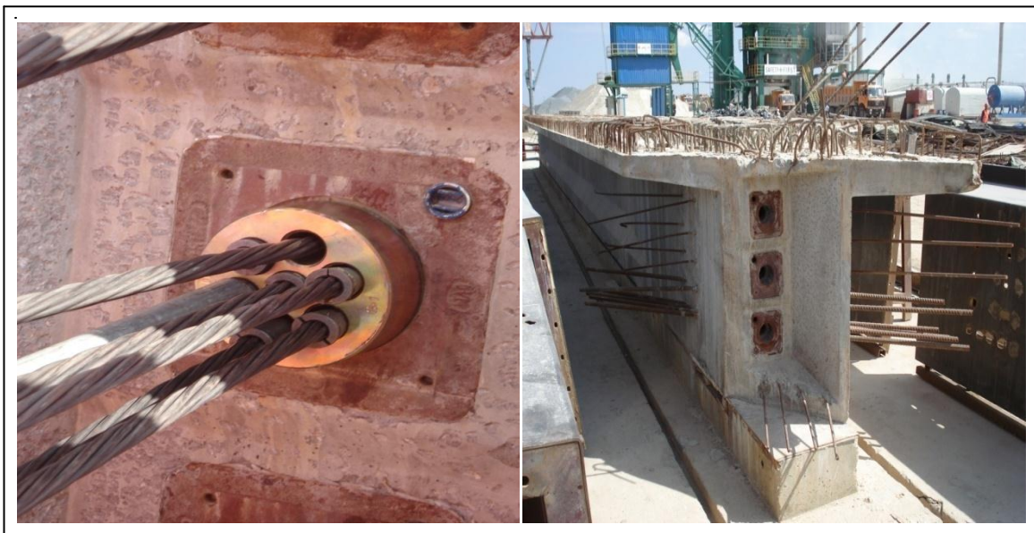
Fig.5.1: Poutre en béton précontrainte
