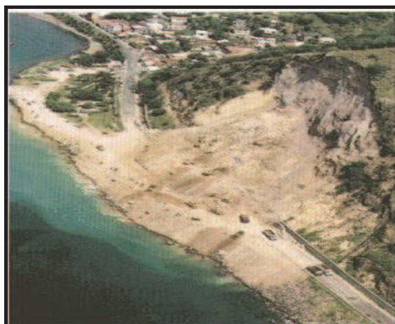
Figure 2.6 L'éboulement de la falaise de Belle Fontaine en 1991 (Ladghem C. F., 2009)
