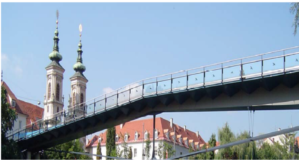
Figure 1.3 : Passerelle Erich-Edegger-Steg à Graz en Autriche
