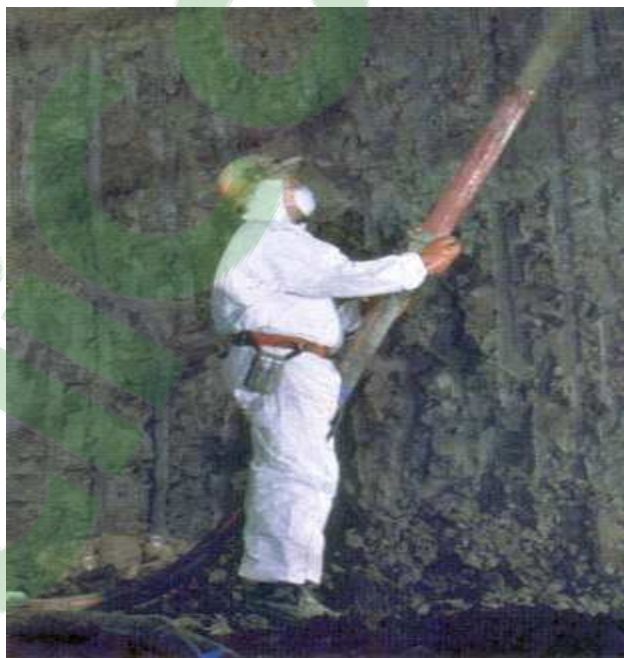
Figure II.16 : Projection par voie sèche [1].
