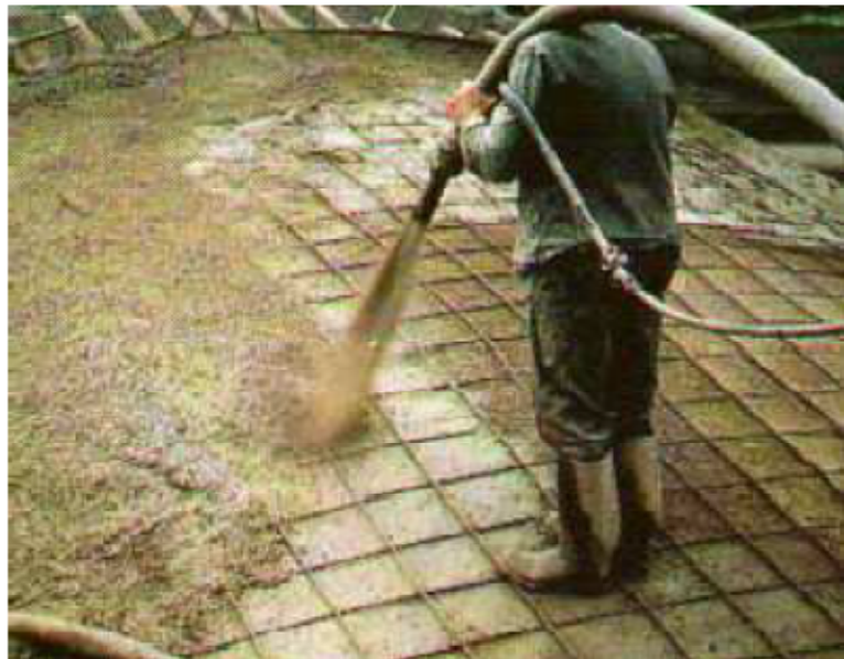
Figure II.17 : Projection par voie humide [2].
