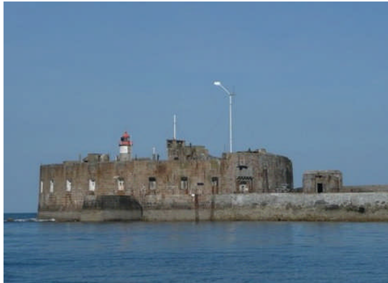
Photo 1 : ouvrages implantés en site maritime [1].
