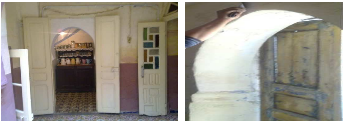
Figure 2.5 : Arc plein centre outrepassé
