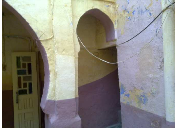
Figure 2.4 : Arc ogival outrepassé
