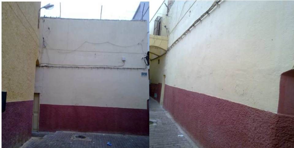
Figure 2.1 : Façade de cette maison
