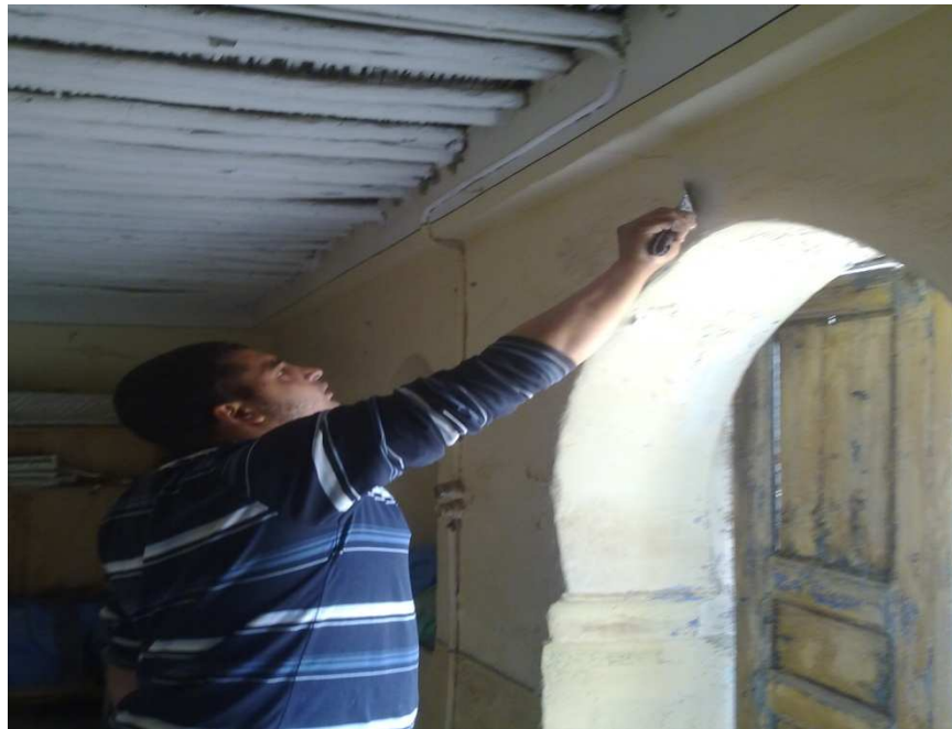
Figure 3.1: Mise en place des plaques témoins
