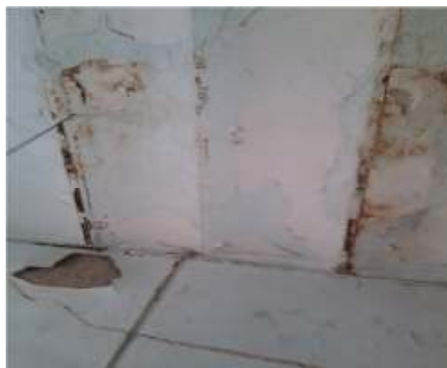
Figure2.23 : plancher en voutains et IPN
