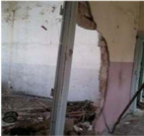
Photos3.2 : Démolition du mur intérieure
