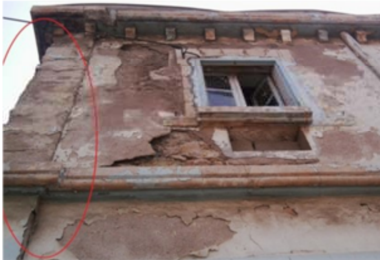
Figure 2.16 : chaînage verticale (chaîne de refend)
