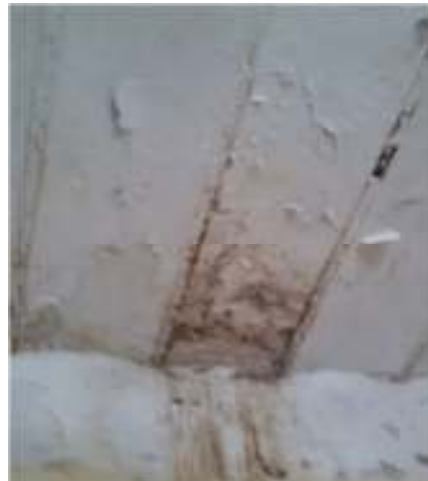
b- oxydation ponctuelle avancée.
