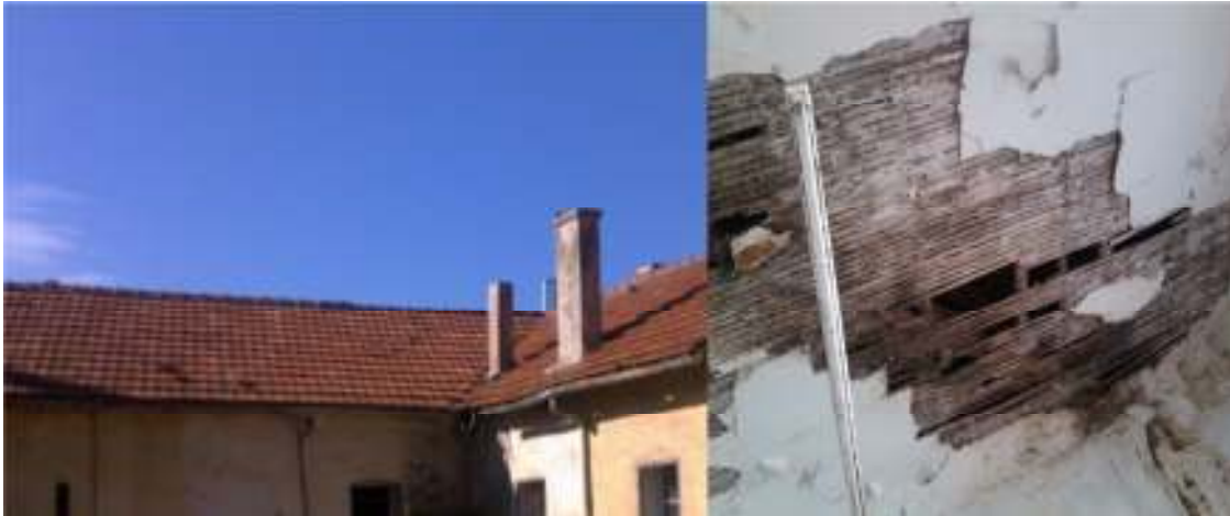
Figure2.24 : ossature en charpente traditionnelle
