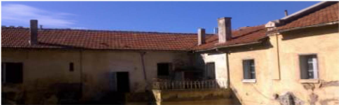
Figure 4.14 : charpente de Toiture
