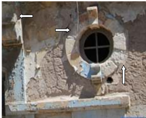
Figure 4.9 : cas visé de traitement par mortier
