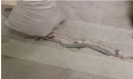
c-placer de délimiter le calfeutrement
