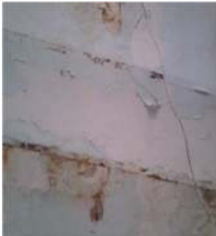
a-Oxydation de profilés métallique.
