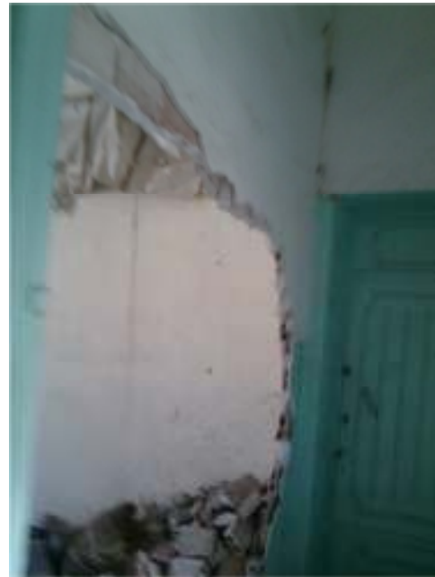
Photos3.2 : Démolition du mur intérieure
