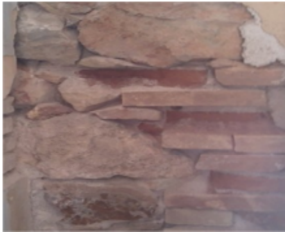
figure4.6 : rejointoiement de mortier d'hourdage
