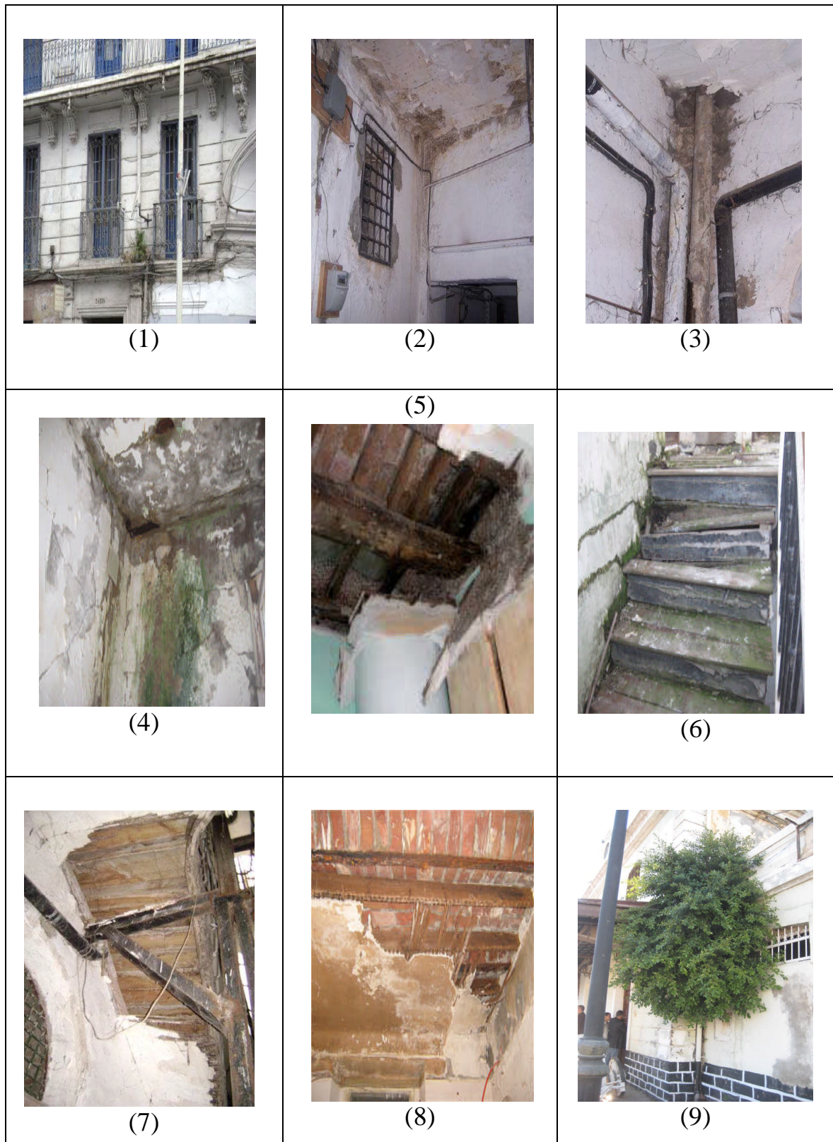
Figure 1.12 : pathologie des enceins bâtis.
