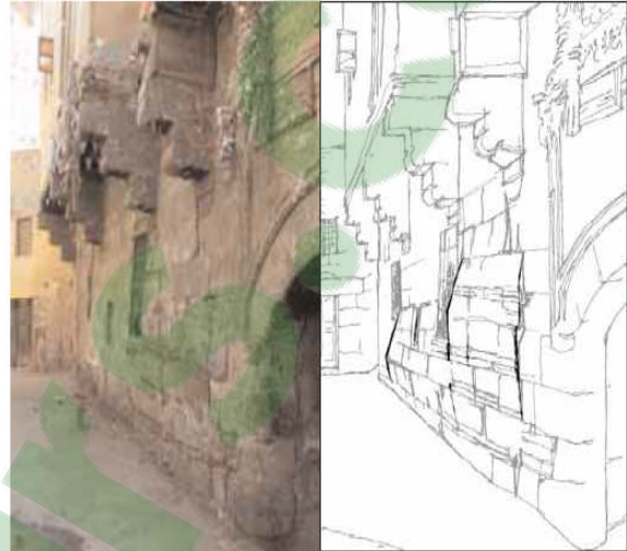
Figure 1.21: Fissure dues au Fractures verticales
