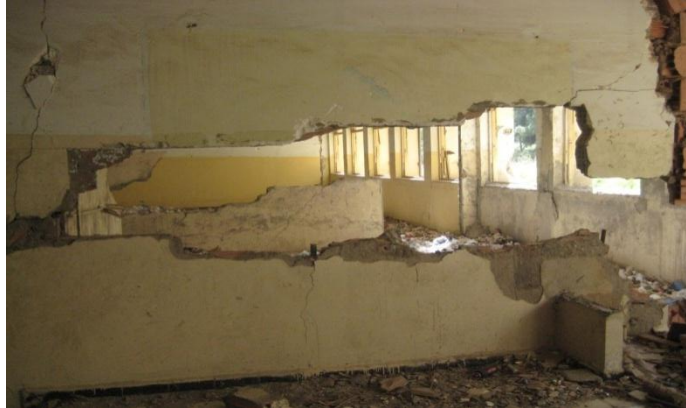
Figure 6.1 : Exemple d'un mur cloison qu'il faut démolir (partie 2, RDC).
