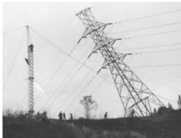
Figure 2.1 : pylône endommagé
