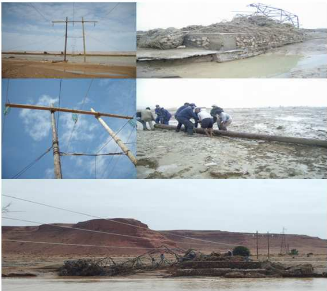
Figure 2.3 : Rétablissement d'une ligne 60 KV en utilisant les portiques en bois
