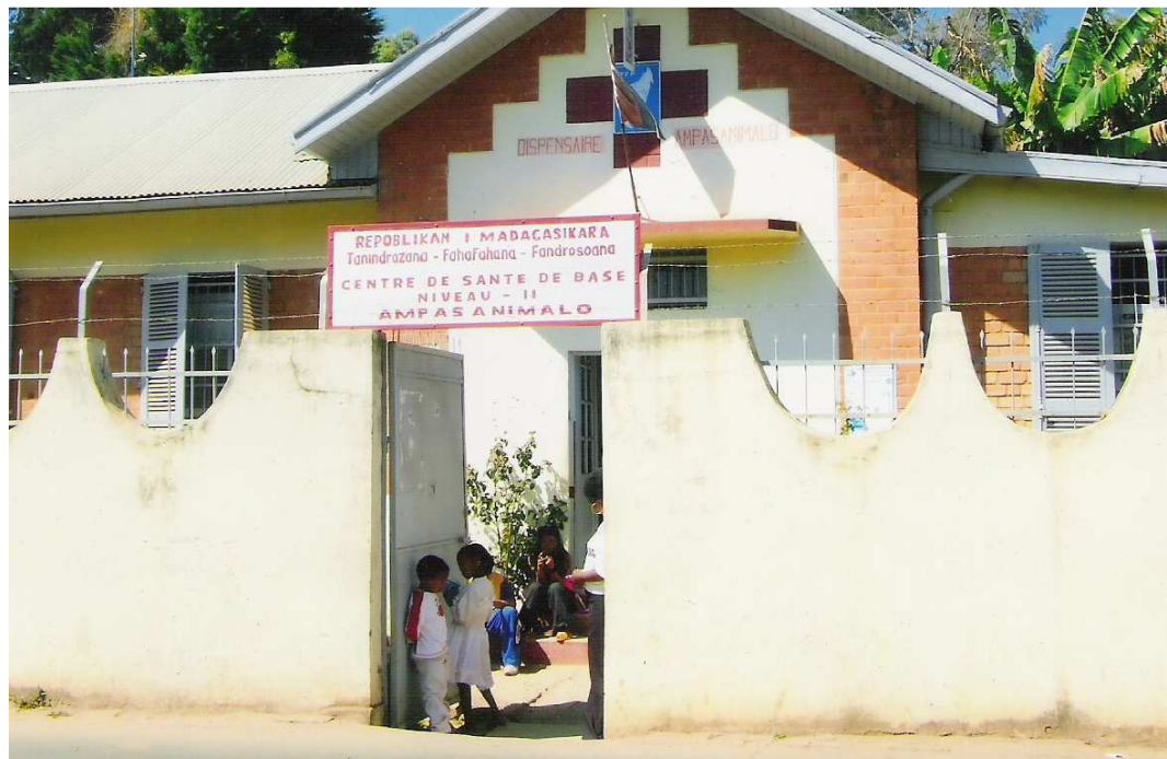
Figure 5 : Le CSB2 d'Ampasanimalo (vue de face).
