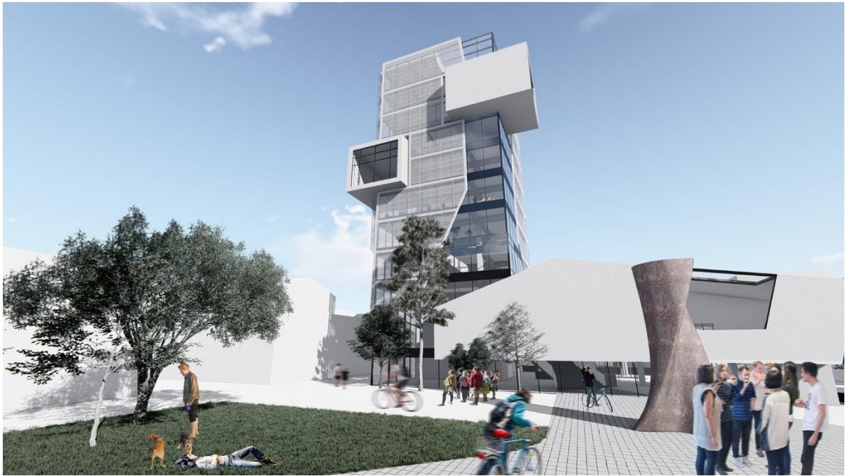
Figure 32 : Vue depuis la place publique
