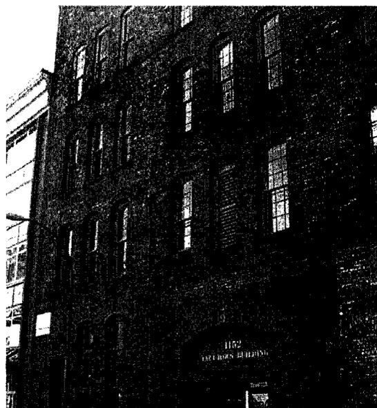
Figure 40 Bâtiment en MNA dont les fenêtres indiquent une plus grande épaisseur de mur au rez-de-chaussée (photo de l'auteure)
