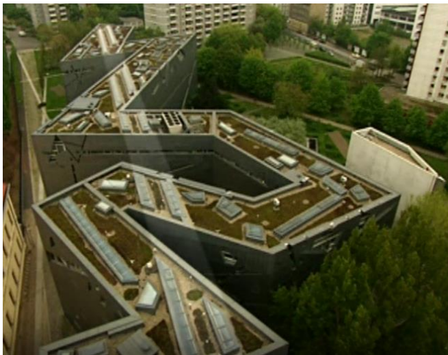
Fig 20 : Vue aérienne montrant l'axe des tours vides
