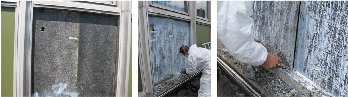
Une fois le verre et le FOAMGLAS retirés, le GLASAL est apparent. Un fixateur est projeté sur l'ensemble afin d'éviter la propagation des fibres d'amiante. Un léger coup de cutter permet de désolidariser le GLASAL du cadre aluminium.
