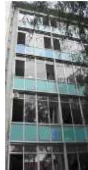
*Fine couche de finition murale en plâtre contenant des fibres d'amiante, couvre mur en amiante ciment et plaques de façade en amiante-ciment de type « Glasal » couche de finition bleu-vert.*
