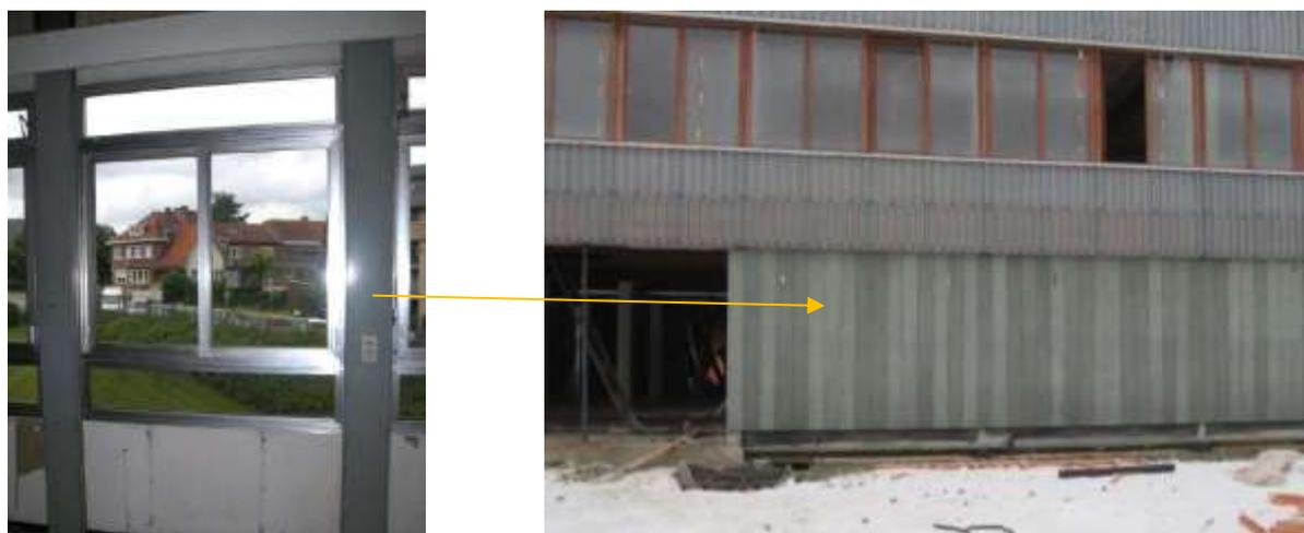
Capots métalliques, utilisés pour protéger les piliers entre les châssis du côté 'intérieur, ils deviennent des éléments de bardage extérieurs sur la nouvelle façade.
