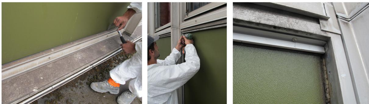
La première opération consiste à "déclipser" les 4 capots en L périphériques. Ensuite il faut dévisser 4 autres capots en L qui assurent l'étanchéité de l'allège (cf: plan et coupe ci-dessus).
