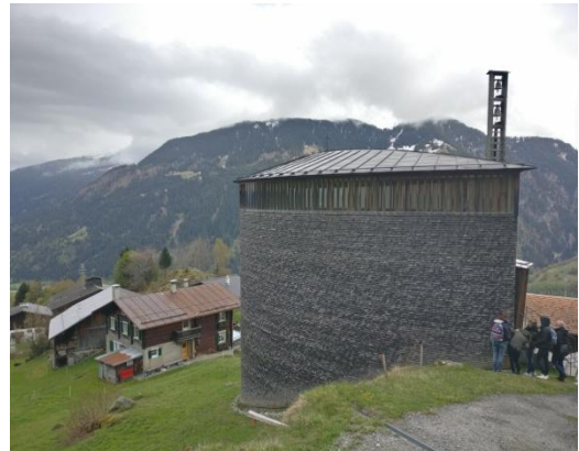
Figure 80 – Vue extérieure, Chapelle ST-Bénédict
