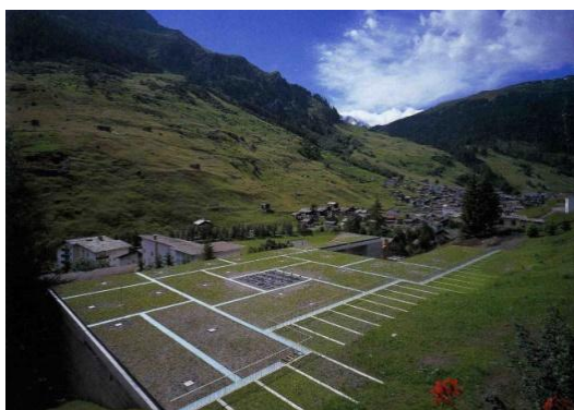
Figure 188 – Toiture plate végétale
