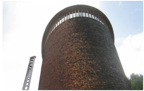
Figure 123 –vue façade Est.
