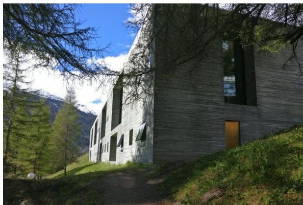
Figure 134 – Façade Nord et Est.
