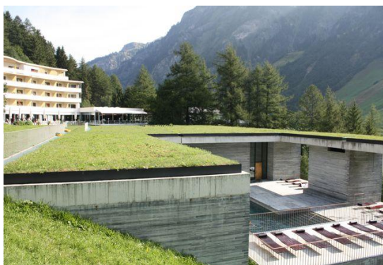
Figure 135 – Toiture plate végétale
