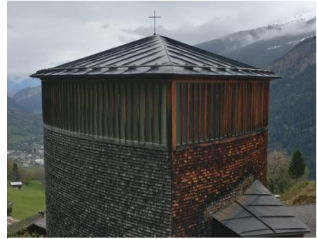
Figure 102 – Vue sur toiture, Zinc.
