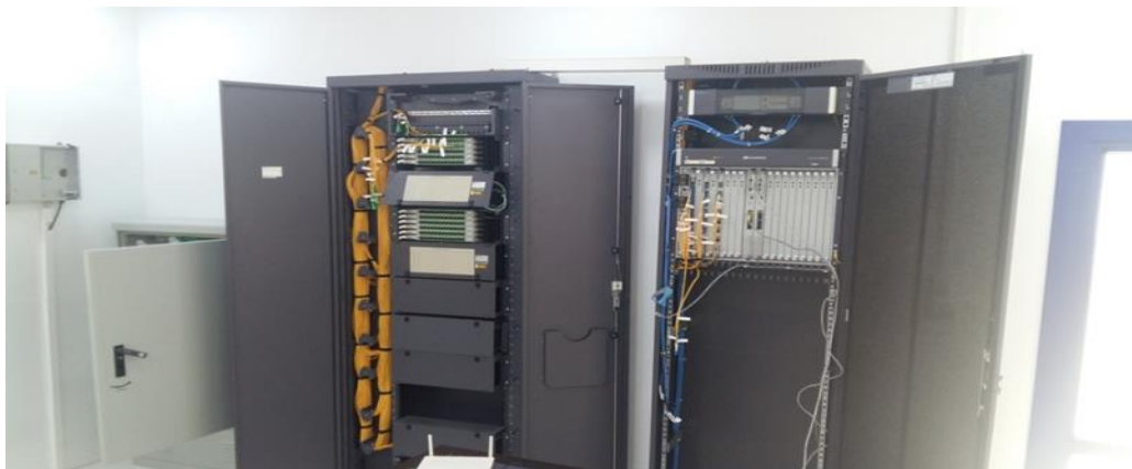
Figure IV.8: Nœud raccordement optique NRO
