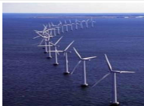
Figure I.6: Photographie d'une ferme éolienne offshore
