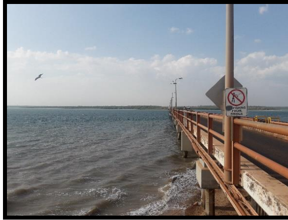
Figure 2.15 : Pont en direction du port
