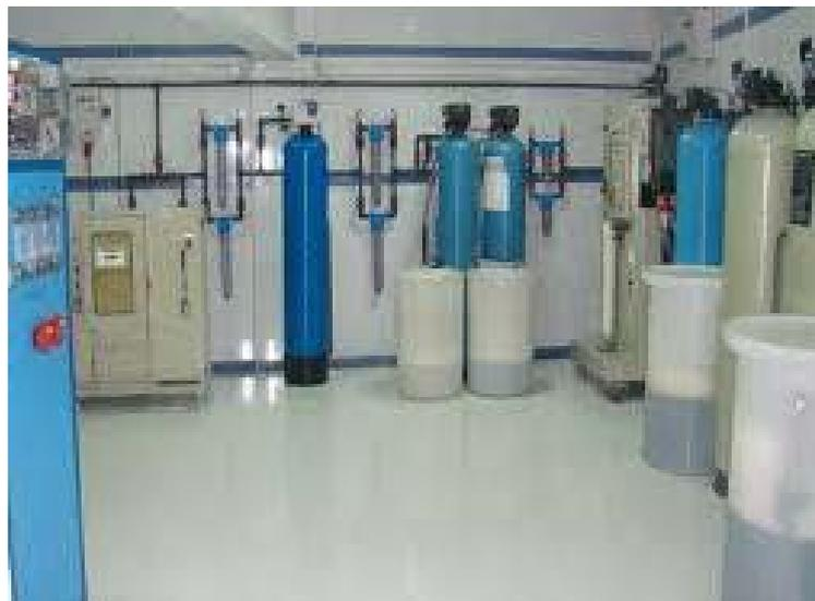
**Figure 15 : Station de traitement d'eau pour hémodialyse**
